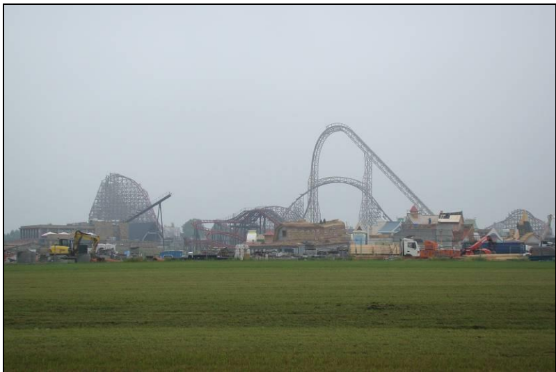
Fot. 17 Energylandia widok od strony południowej
